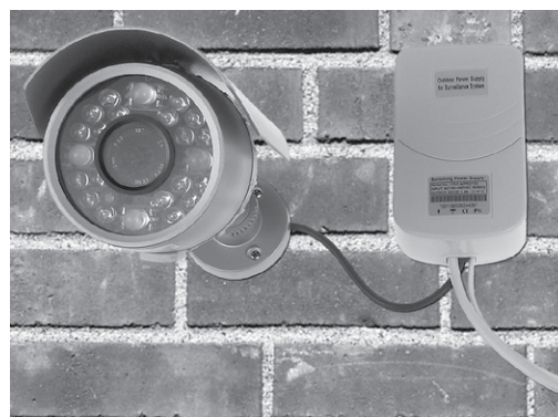
Zasilacz zainstalowany w pobliżu kamery (wszystkie złącza wewnątrz obudowy zasilacza)
